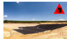
Relleno de seguridad
