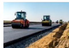
Material de relleno en infraestructura
