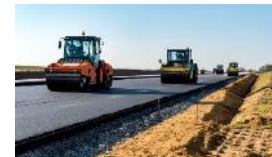
Material de relleno en infraestructura
