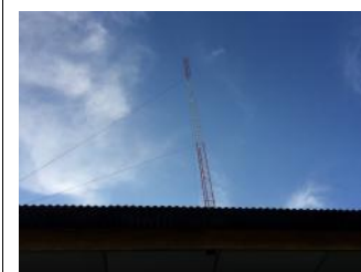
Foto N° 8 Instalación de antena
